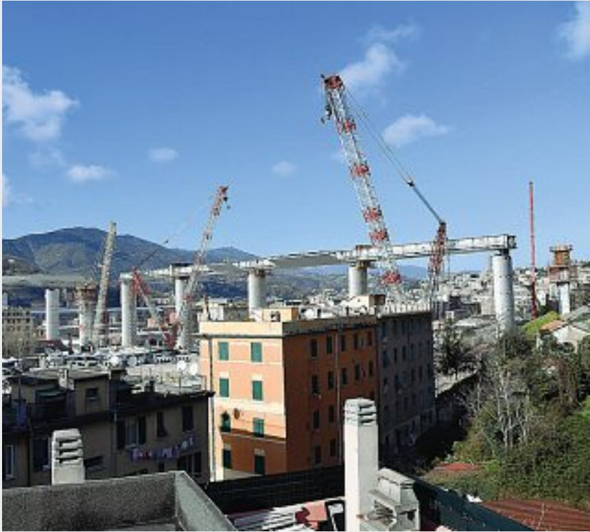
Viadotto Le ultime pile in costruzione del nuovo ponte sul Polcevera a Genova (foto Ansa)
