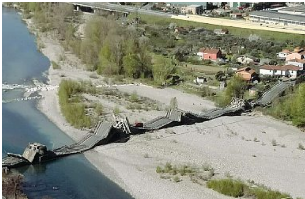
Dall'alto Quel che resta del ponte crollato nei pressi di Aulla, in provincia di Massa Carrara (Pecoraro/LaPresse)
