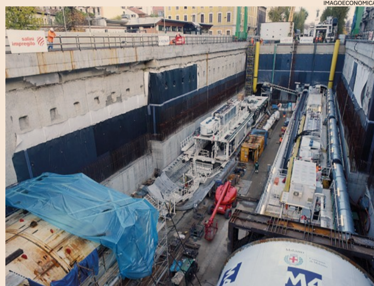
Metropolitana M4. Sono ripresi ieri i lavori per la linea 4 a Milano
