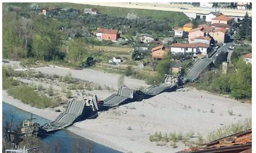
Accartocciato Il ponte crollato ad Albiano (Massa Carrara) sul fiume Magra: 258 metri, unisce Liguria e Toscana
