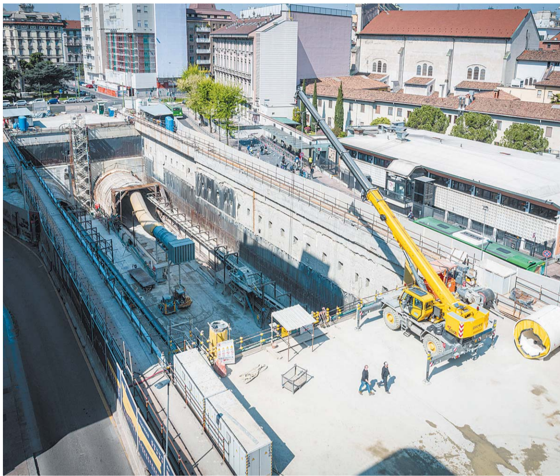
Il cantiere della M4 in piazza Tricolore, dove ieri sono tornati gli operai al lavoro per la costruzione della metropolitana (Fotogramma)
